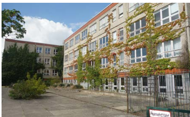
Schulcampus vor der Sanierung
