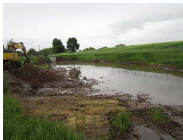
Becken bei der Entschlammung
