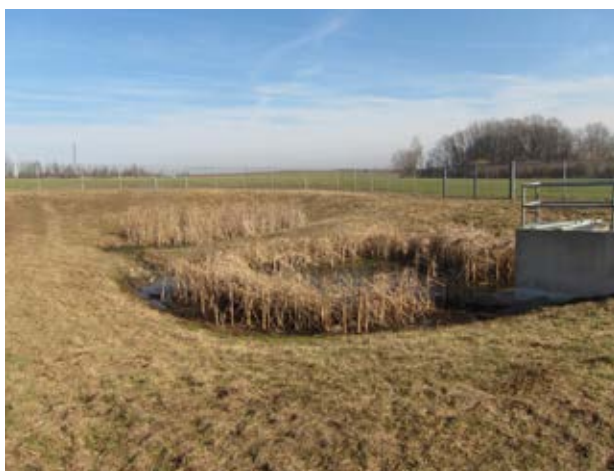
Becken vor der Sanierung
